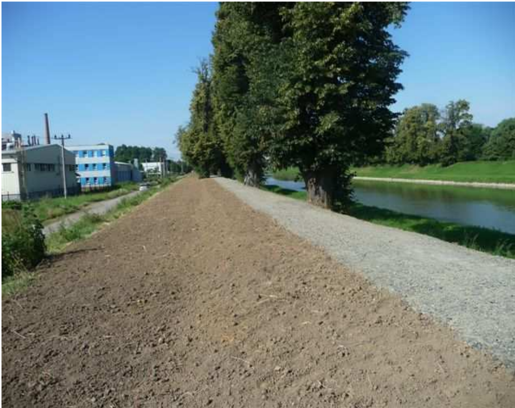
Obr. 7. Úprava hrází podél řeky Moravy – I. etapa [25]
