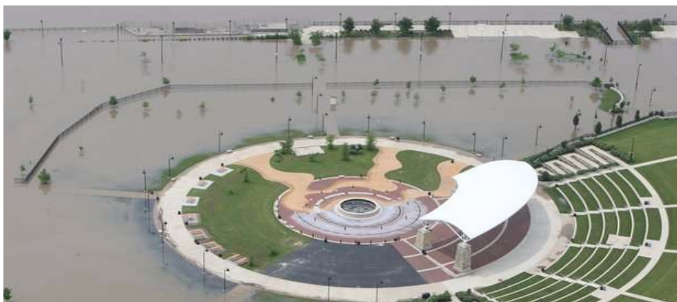
Obrázek 5 Rozvodněná řeka Mississippi [5]
