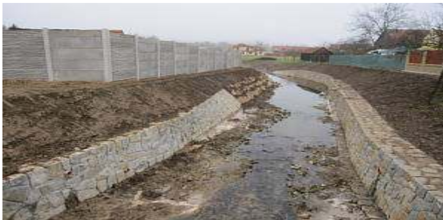
Obrázek 11 Protipovodňové opatření v Drslavicích [13]
