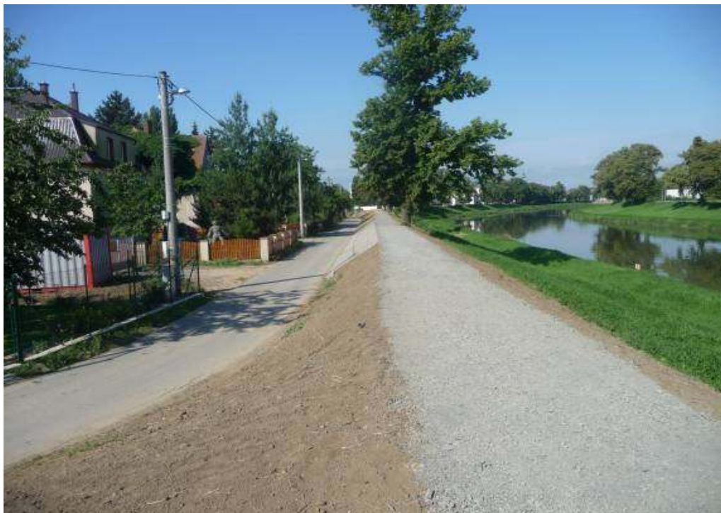
Obrázek 12 Zvýšení kapacity koryta [19]
