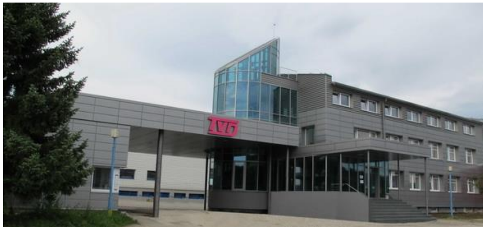
Obrázek 10 Správní budova společnosti (TVD – technická výroba a.s., © 2009)
