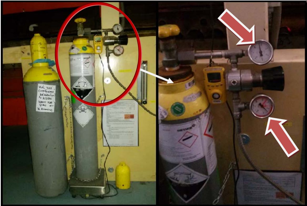
Obrázek 13 – Chybějící značení optimálního rozsahu (vlastní zpracování)
