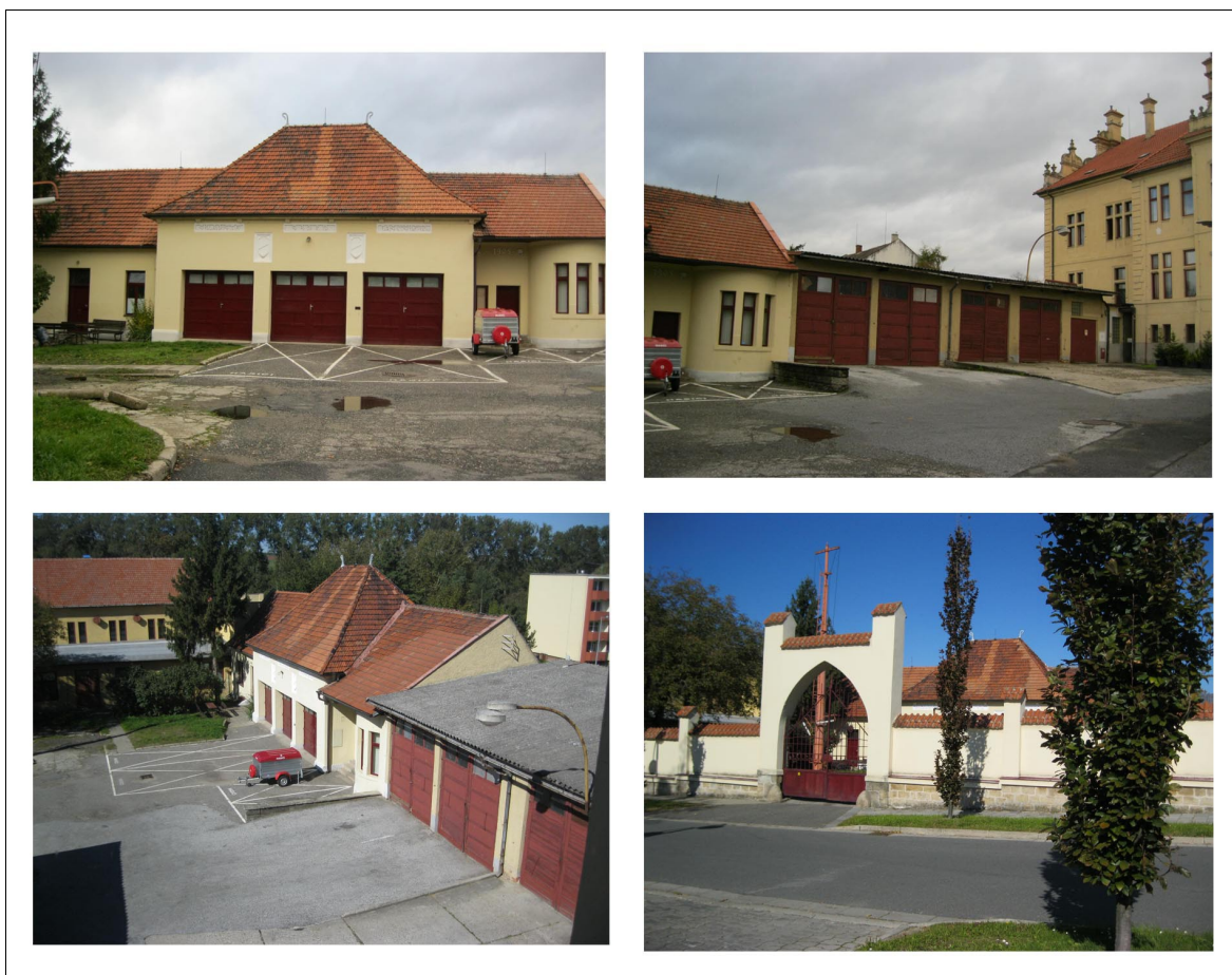
Obr. 39. Současný stav hasičské zbrojnice
