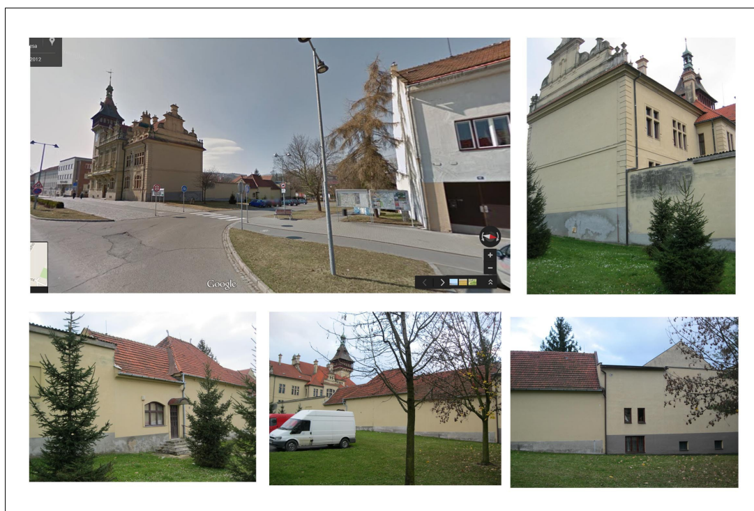
Obr.56. Pohled na zděnou hradbu tvořenou zadní částí budov městského centra
