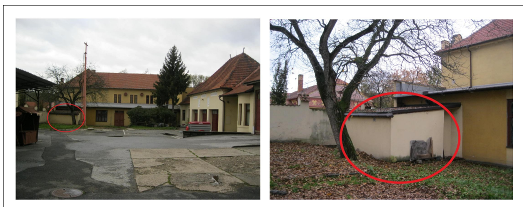
Obr. 44. Sokolovna – přístavba výčepu ke hmotě budovy přistavěné v roce 1934
