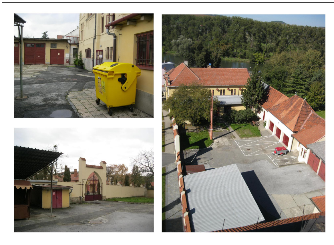
Obr.57. Izolovanost radničního dvora
