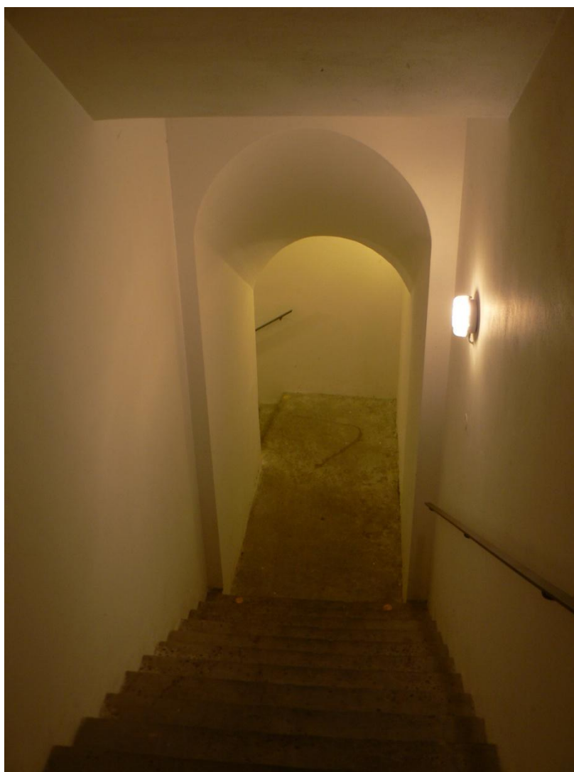
Obr. 12 Hlavní chodba vedoucí do sklepení Reduty
