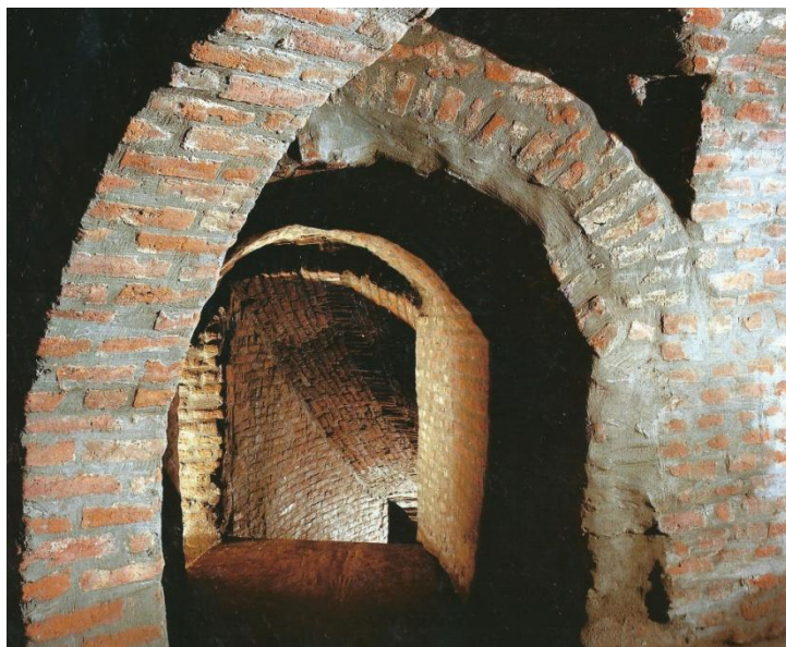
Obr. 37 Sklepy domu č. 13, vstupní chodba
