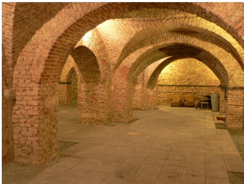
Obr. 11 Severní část sklepení Reduty
