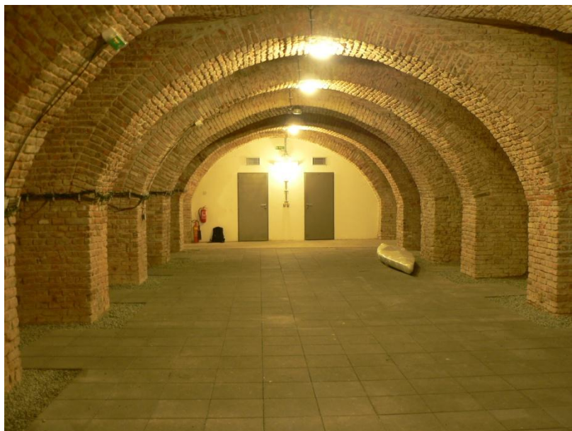
Obr. 10 Západní část sklepení Reduty
