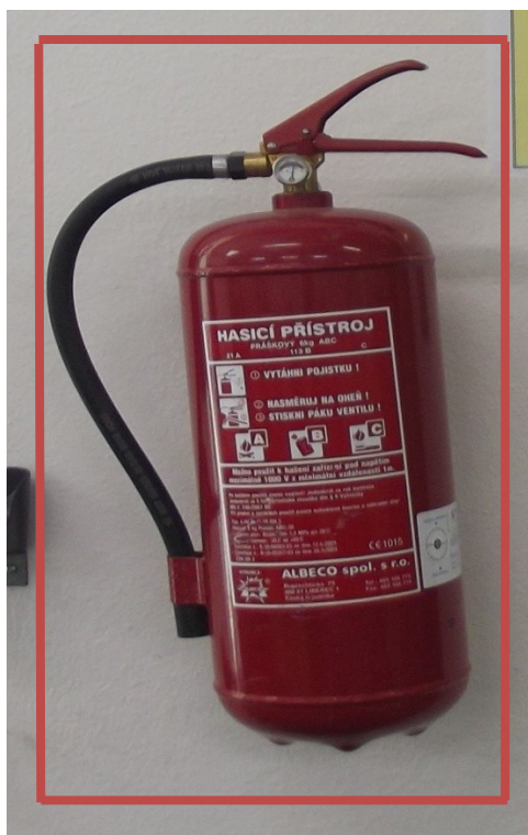
Obrázek 22: Označení hasicího přístroje (zdroj: vlastní zpracování)
