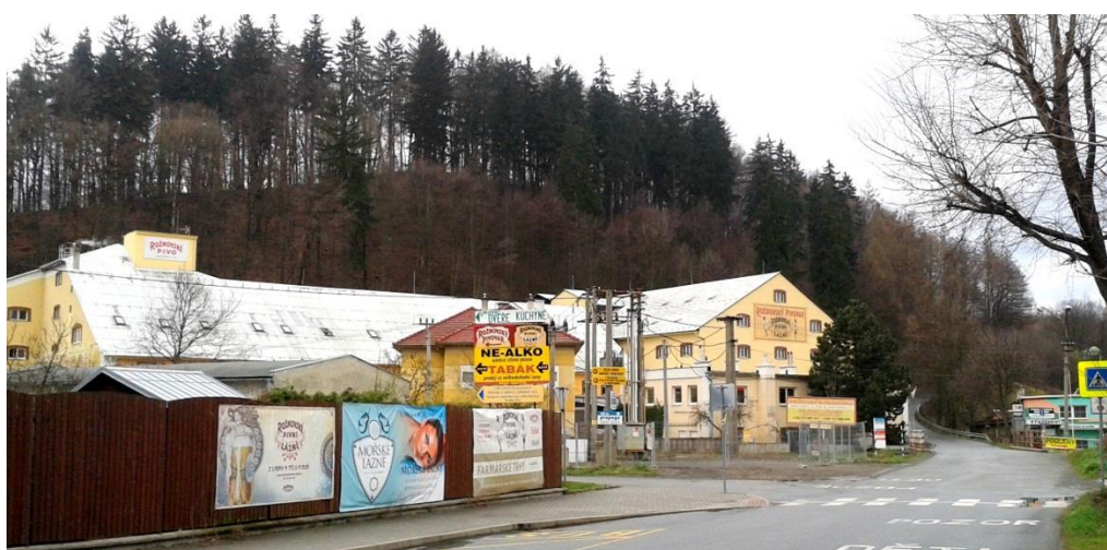
Obr. 17. Pohled na areál z pozemní komunikace
