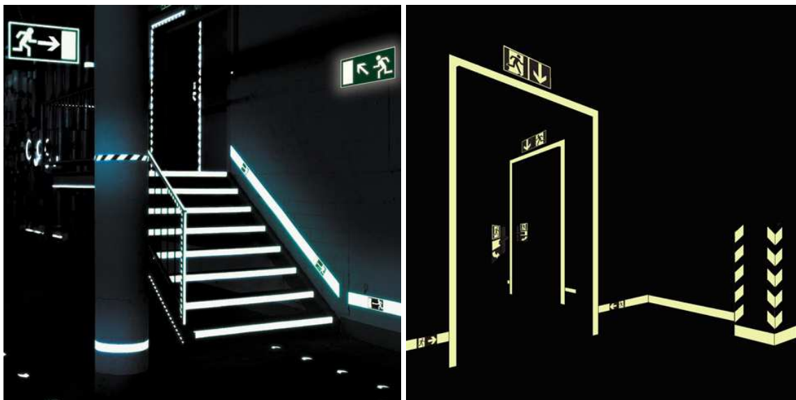
Obr. 17. Zobrazení funkce fotoluminiscenčních bezpečnostních tabulek a nálepek, nepodlahového a podlahového značení směru únikové cesty [zdroj vlastní]
