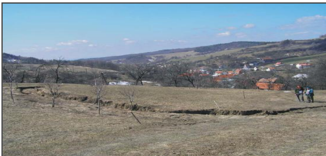
Obrázek 5. Všemina, pohled na horní část sesuvu. [22]
