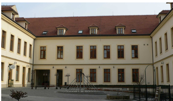
Obr. 2. Pohled z nádvoří
