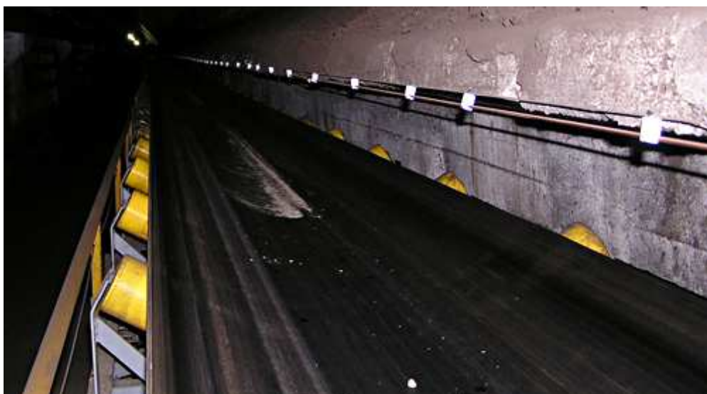
Obr. 10. Použití Transsafe ADW 511 nad pásovými dopravníky uhlí
