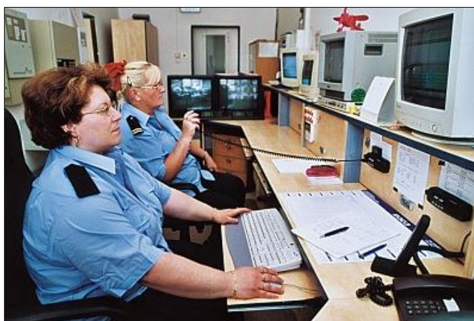
Obr. 16. Elektronická ostraha objektů
