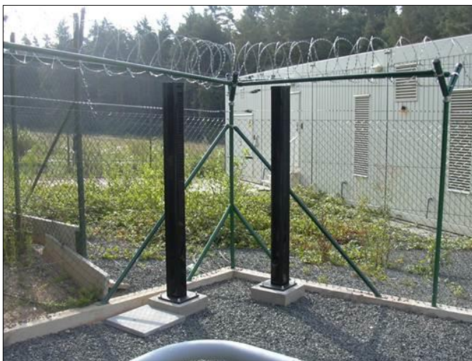
Obr. 8. Perimetrická ochrana objektu
