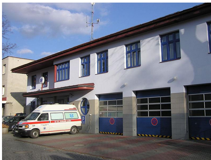
Obr. 54 – Výjezdové stanoviště ve Vsetíně [12]
