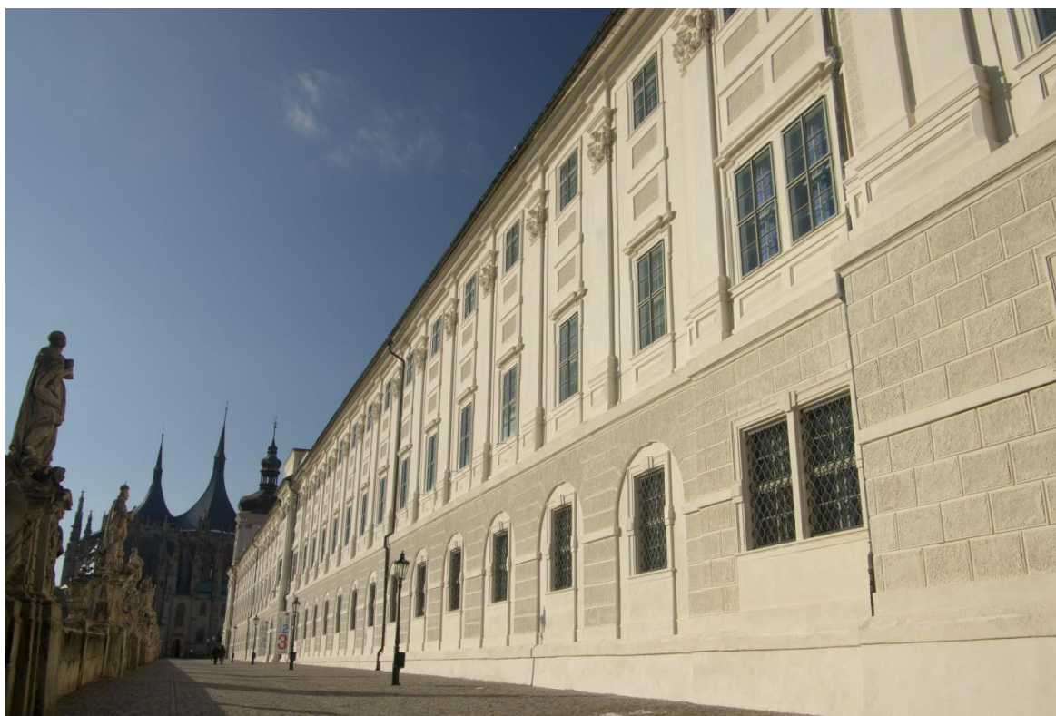
Obrázek 10: Pohled na budovu GASK z východní strany
