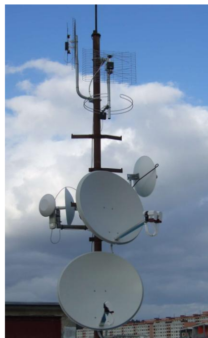
Obrázek 64 Osazení anténního stožáru [vlastní zdroj]
