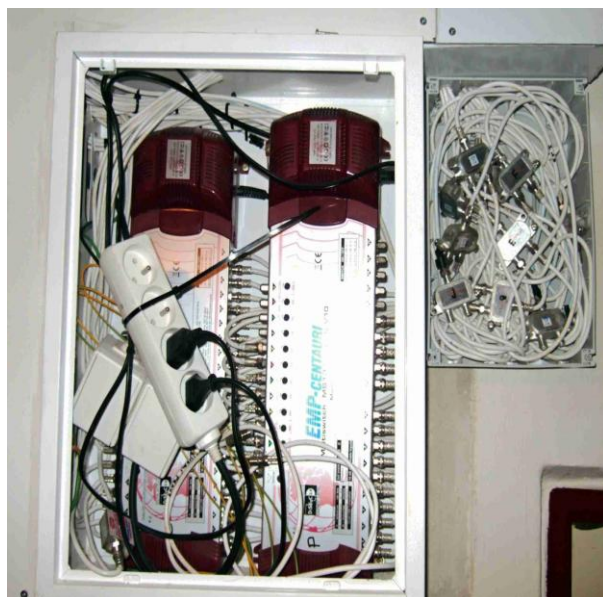
Obrázek 68 Nevhodné umístění hlavní stanice [vlastní zdroj]
