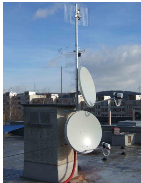
Obrázek 62 Osazení anténního stožáru [vlastní zdroj]
