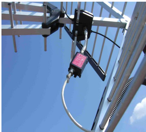
Obrázek 65 Neodborné zapojení předzesilovače [vlastní zdroj]
