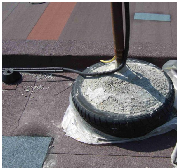
Obrázek 66 Amatérské provedení anténního stožáru [vlastní zdroj]
