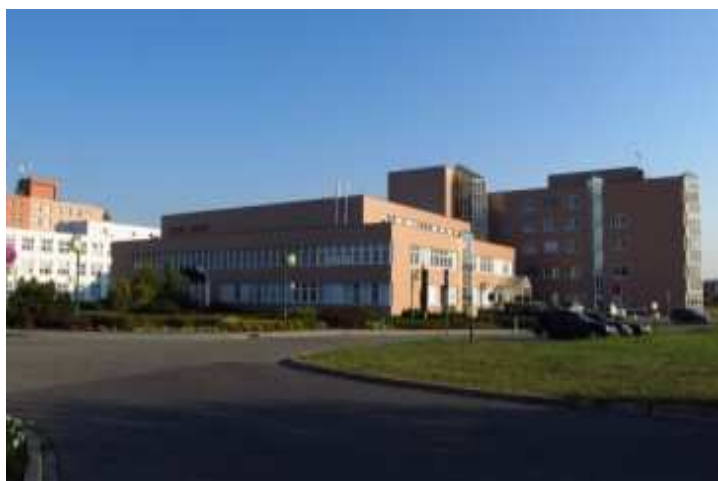
Obr. 23 Nemocnice Prostějov, druhá část,
