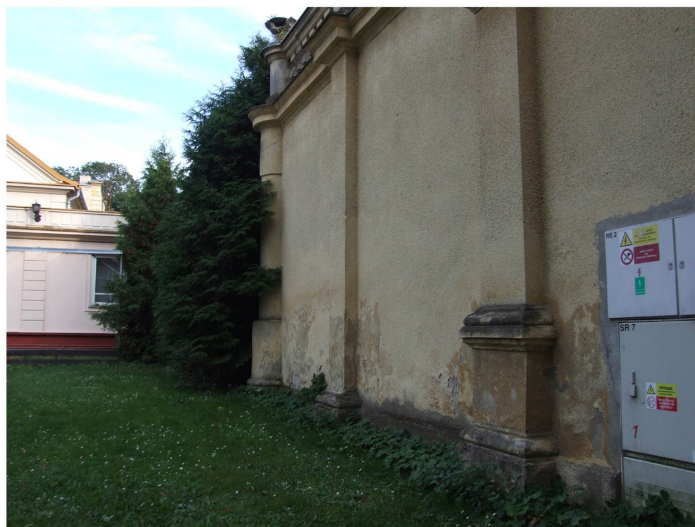
Obr. 21. Severní stěna kavárny
