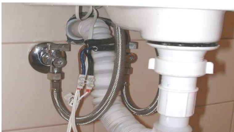
Obr. 8 Přípojka umyvadlové baterie [14]
