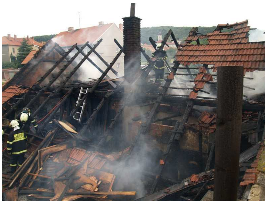
Obr. 5 Částečně vyhořený dům [3]
