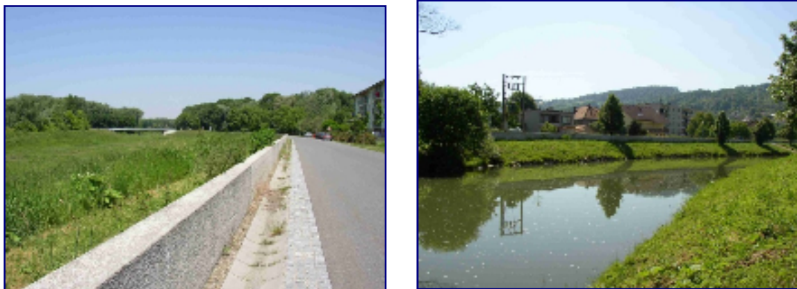
Obrázek 8: Vlevo ochrana Otrokovic, vpravo nábrežní zdi v Přílukách ve Zlíně
