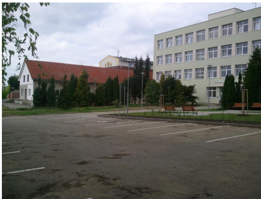
Obr.: 2 Pohled na jižní stranu objektu
