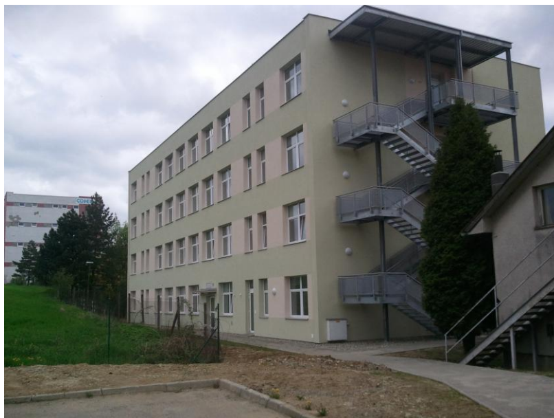
Obr.: 3 Pohled na severní stranu od stávajícího domova pro seniory
