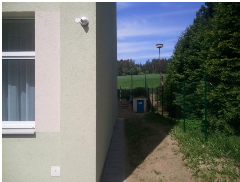
Obr.: 11 Venkovní kamera na jižním rohu budovy
