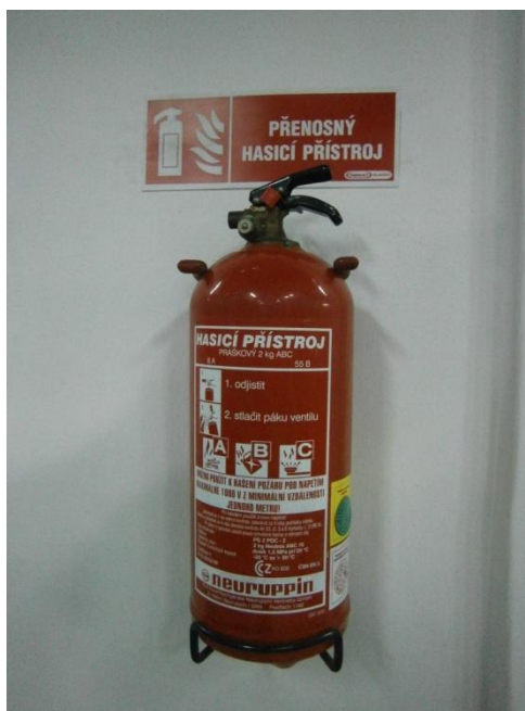
Obr. 9. Práškový hasicí přístroj
