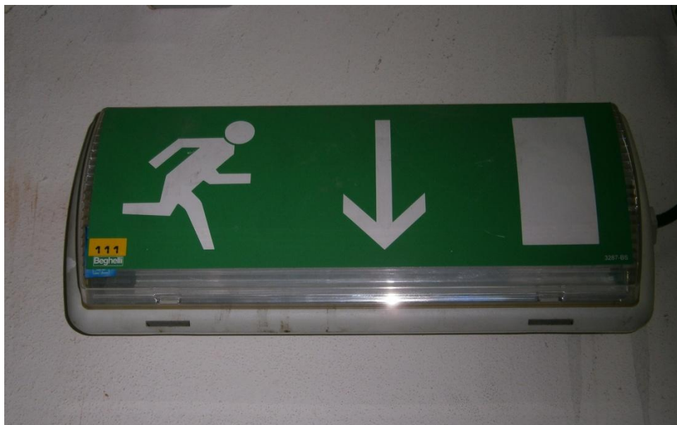
Obr. 6. Osvětlené značení únikových cest [Zdroj: vlastní]
