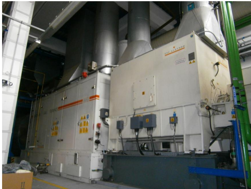
Obr. 4. Spalovací turbína [Zdroj: vlastní]
