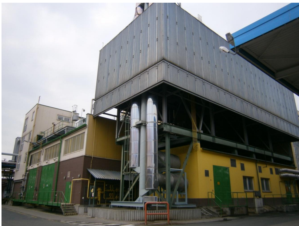
Obr. 3. Budova Teplárny Kyjov a.s. [Zdroj: vlastní]
