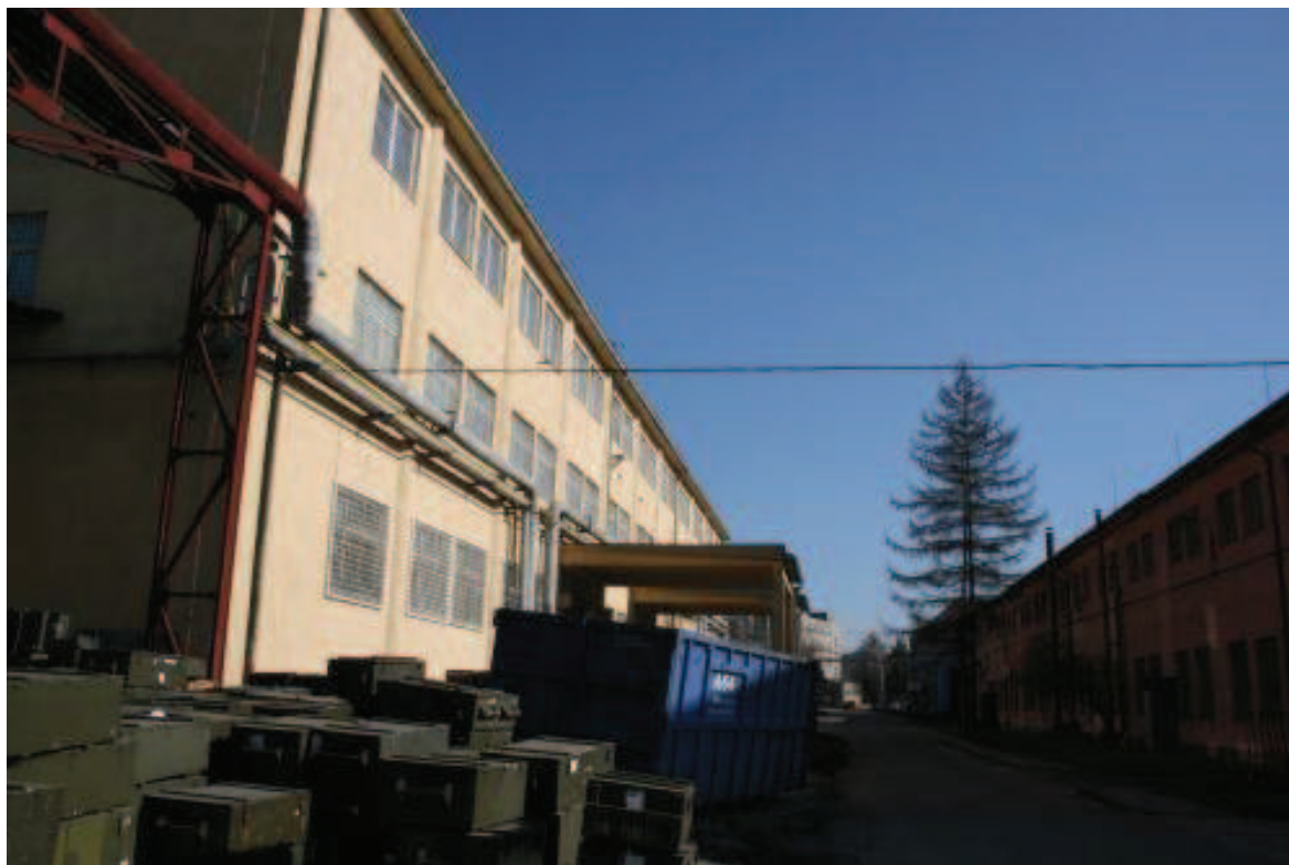
Obr. 16. Pohled na jižní stranu budovy [Zdroj: vlastní]
