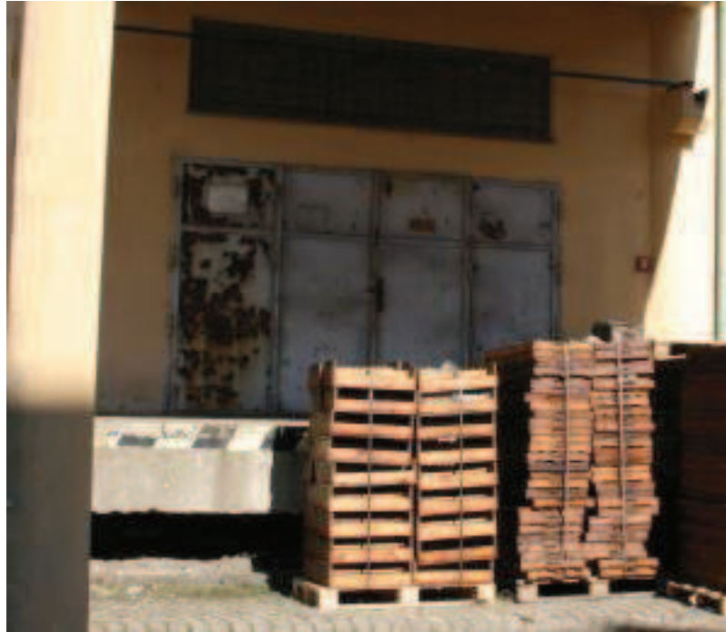
Obr. 6. Zazděné trezorové dveře [Zdroj: vlastní]
