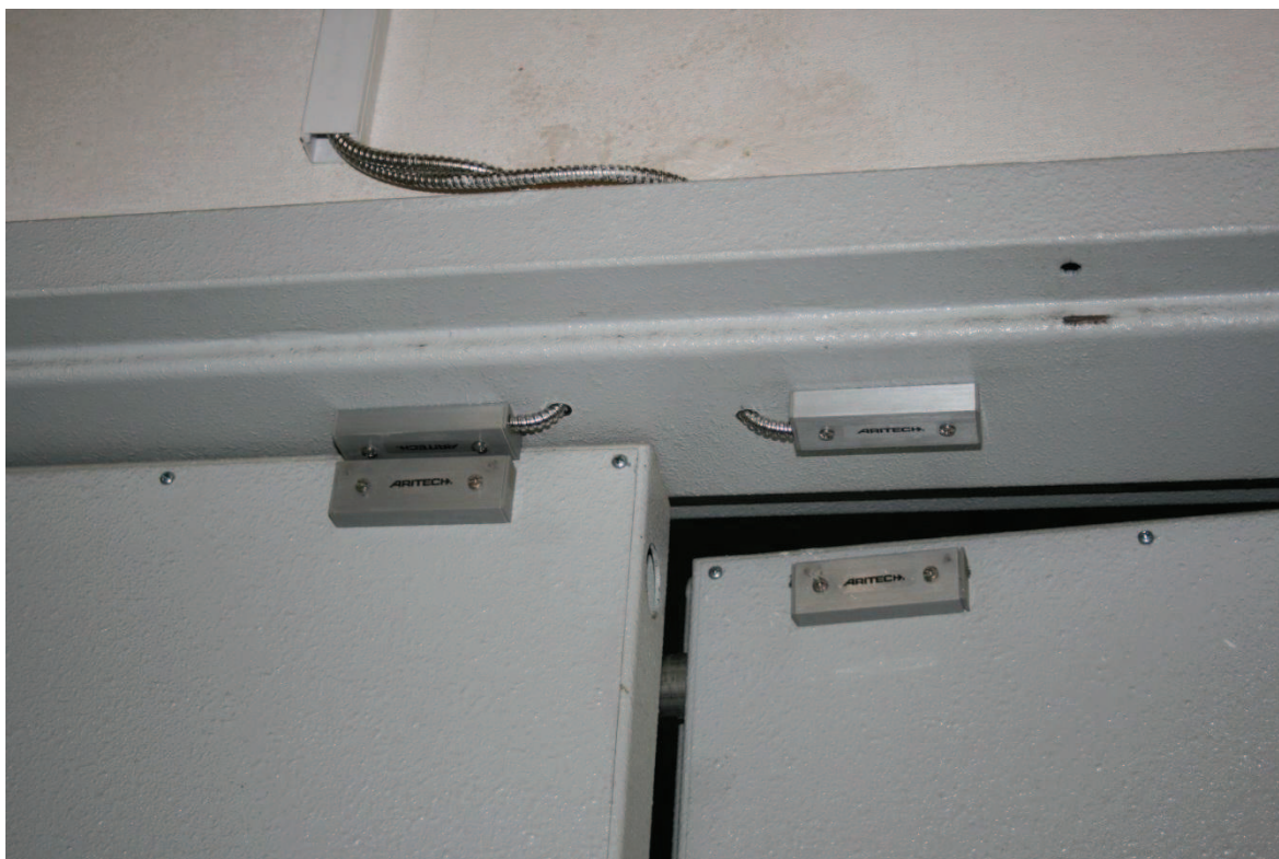
Obr. 21. Magnetické kontakty na hlavních trezorových dveřích [Zdroj: vlastní]
