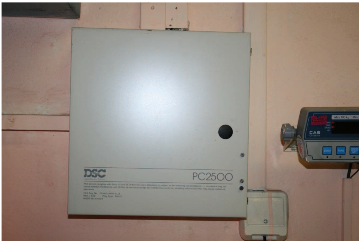
Obr. 23. Ústředna EZS [Zdroj: vlastní]
