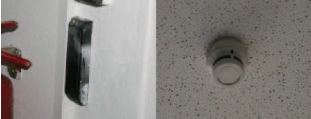
Obr. 12. Čtecí hlava ASR 503 a požární čidlo ORM 140 [Zdroj: vlastní]
