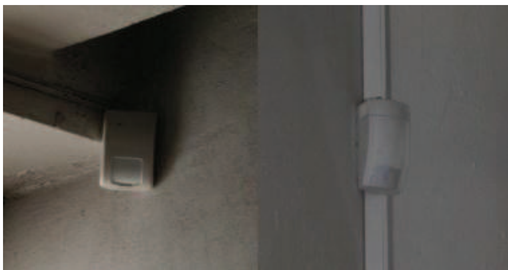
Obr. 10. PIR čidla pohybu EV 125 a EV 100 [Zdroj: vlastní]
