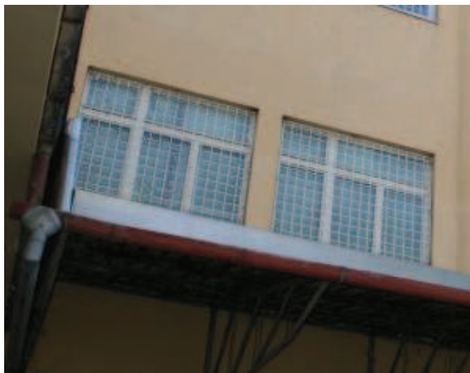
Obr. 9. Zabezpečení oken mřížemi [Zdroj: vlastní]
