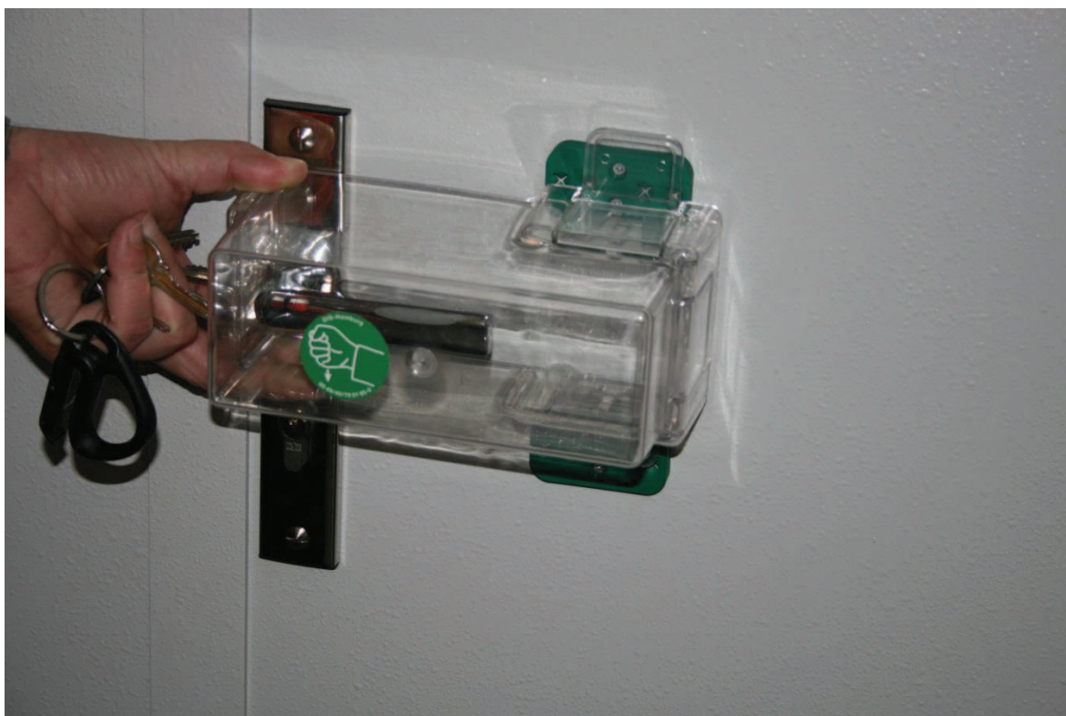
Obr. 22. Bezpečný únik – zajištění únikových dveří [Zdroj: vlastní]
