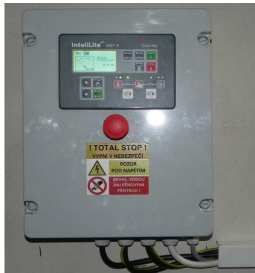
Obrázek 13 - Panel ATR [Zdroj: vlastní]
