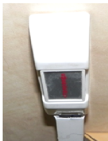
Obrázek 11 - Poplachové tlačítko [Zdroj: vlastní]
