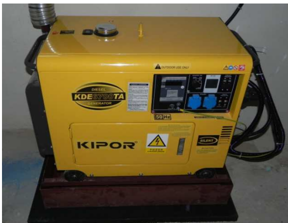
Obrázek 12 - Elektrocentrála záložního zdroje [Zdroj: vlastní]
