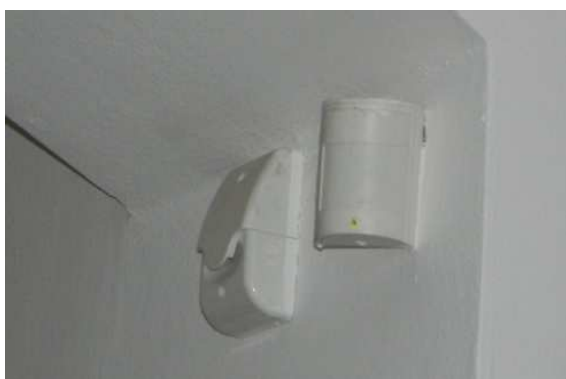
Obrázek 10 - Vnitřní siréna a PIR detektor [Zdroj: vlastní]
