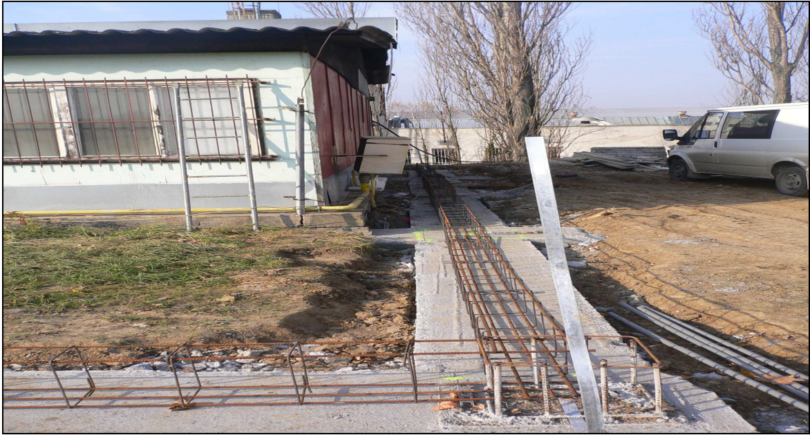
Obr. 4 Firma v době rekonstrukce, její rozšíření, rok 2001 (vlastní fotografie)
