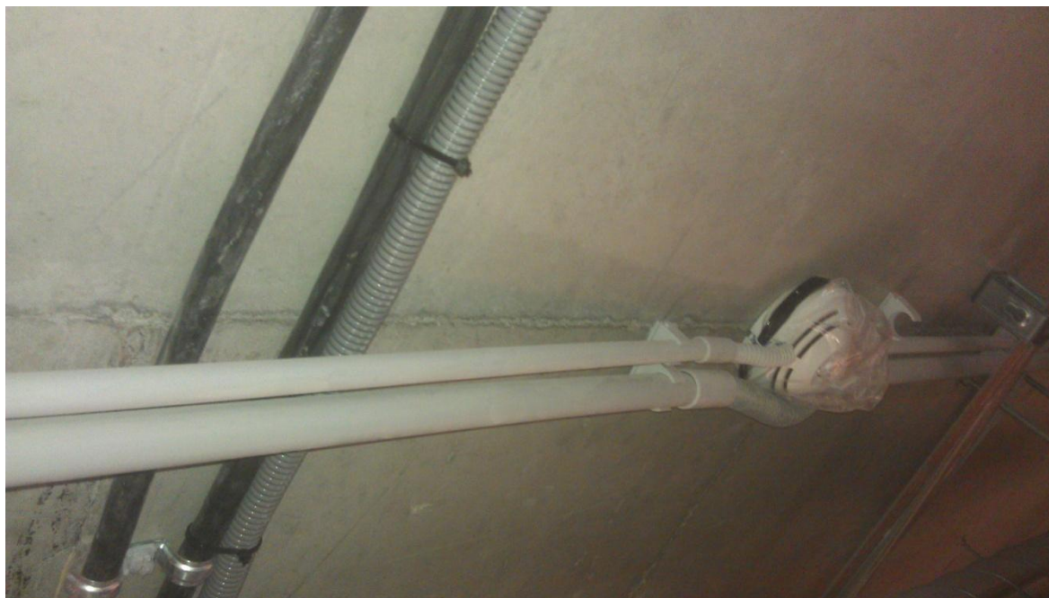
Obr. 22 Přichycení kabelové trasy k rozvodům EPS
