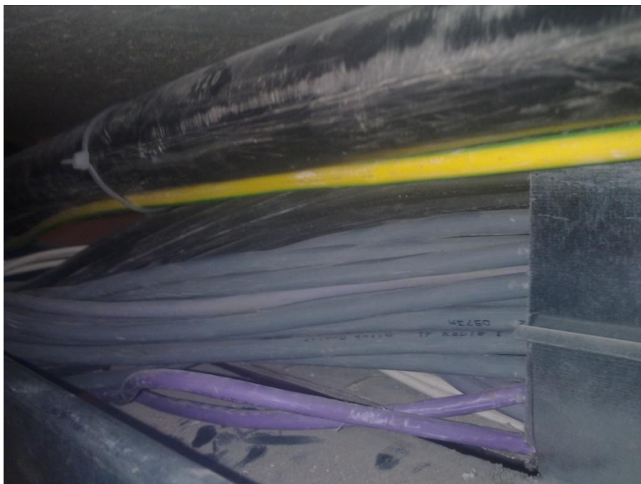
Obr. 20 Ignorování problematiky EMC ve žlabu
