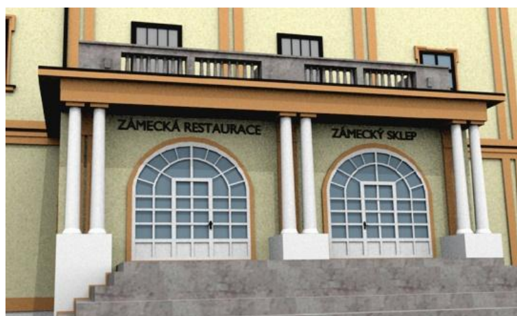
Obr. 17. – Detail vchodové průčelí a balkónek
