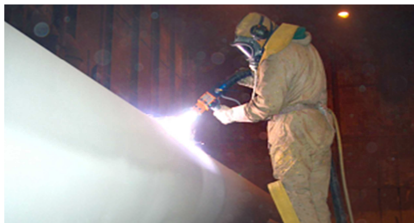
Obr. 5: Příklad žárové metalizace plastového potrubí
