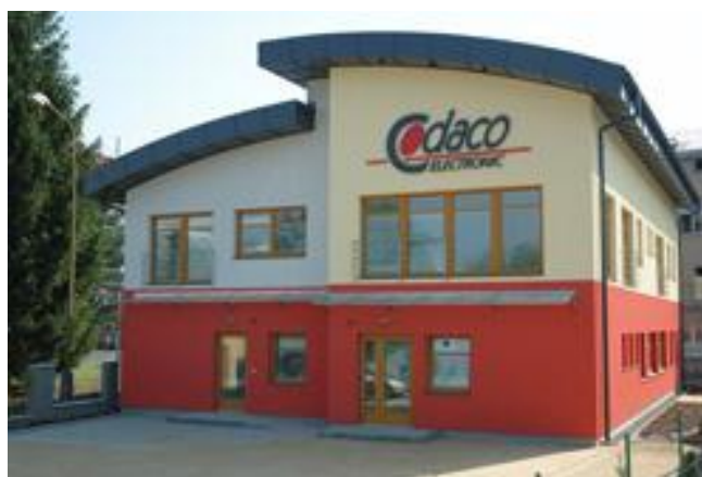
Obrázek 9 – Sídlo společnosti Codaco (CODACO ELECTRONIC S.R.O., © 2002-2010)
