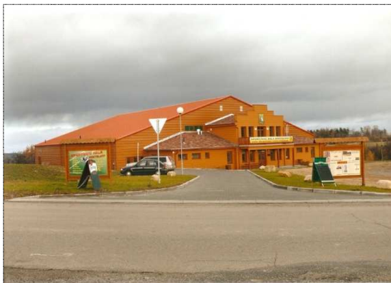
Obrázek 6 – Sportovní víceúčelová hala Kostelany, zdroj: Obec Kostelany © 2013
