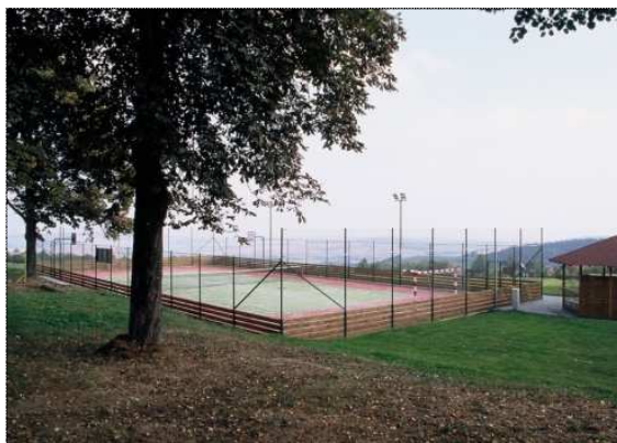
Obrázek 7 – Venkovní hřiště, zdroj: Obec Kostelany © 2013
