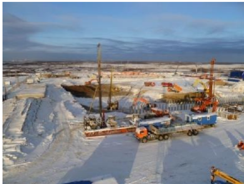
Obr. 7 Realizace paroplynárny, RF
