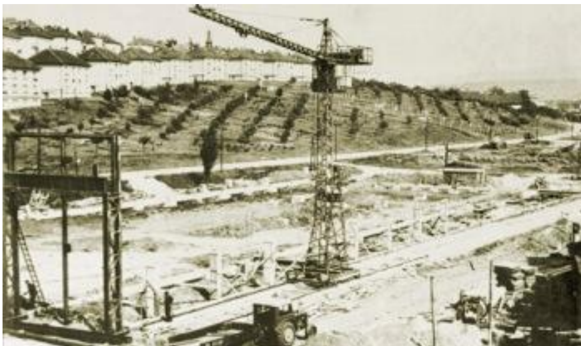
Obrázek 18 Výstavba areálu továrny (Česká zbrojovka)
