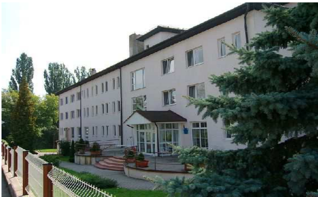
Obr. 2 Budova Centra služeb pro seniory Kyjov
