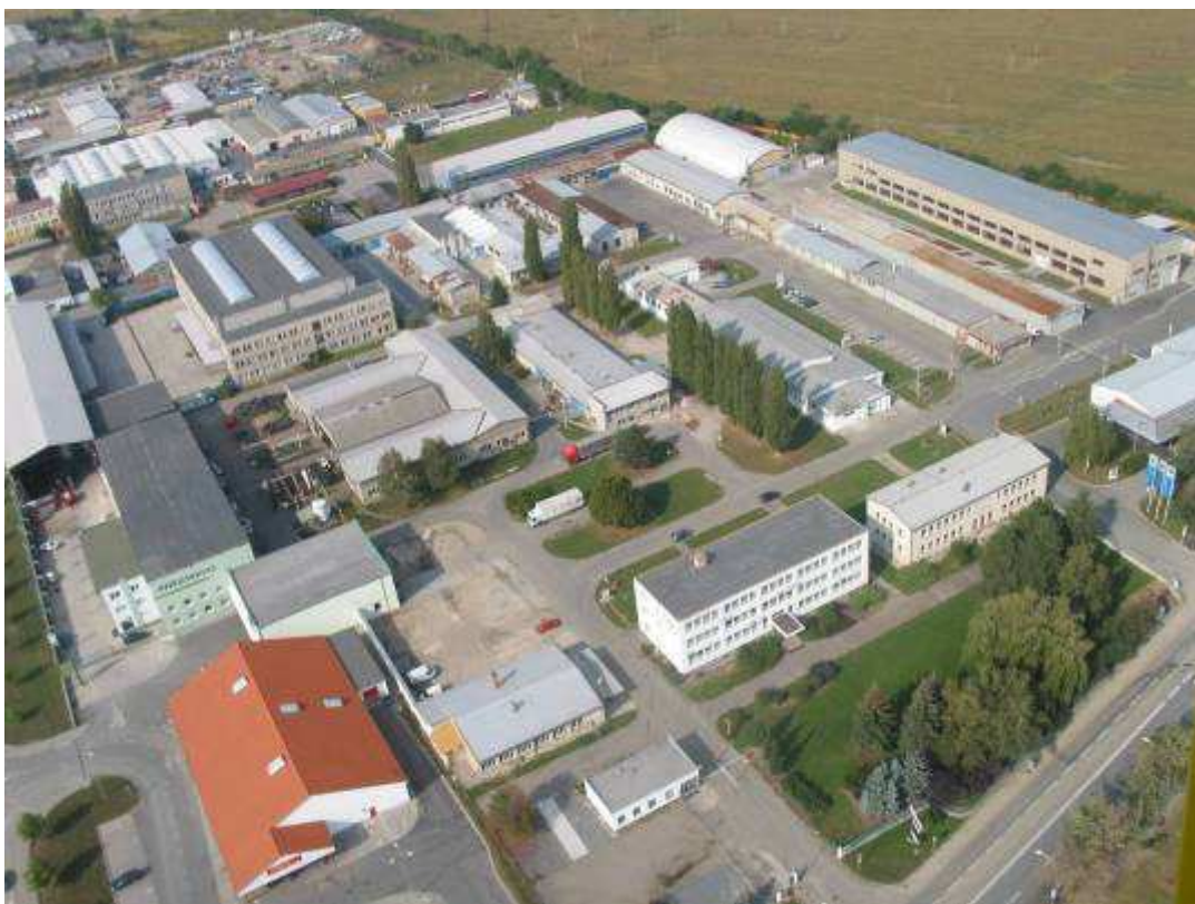
Obr. 5: Areál společnosti Kromexim se sídlem vedení (interní materiály firmy)
