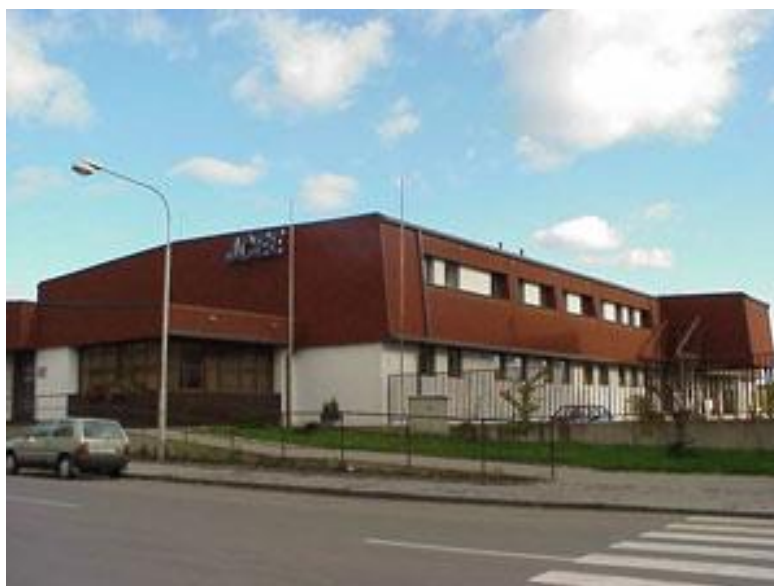
Obr. 5 Sídlo společnosti JCEE, s.r.o. (web JCEE)
