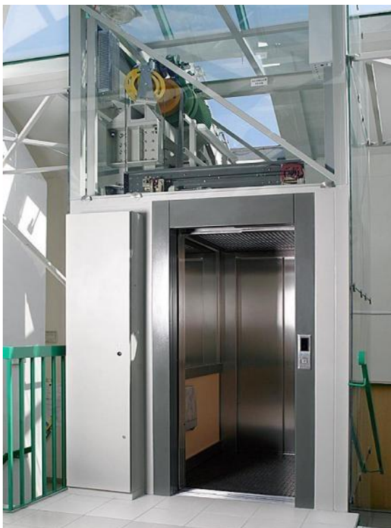
Obrázek 15: Výtah bez strojovny [24]
