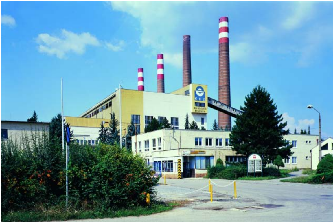
obr. 6: Elektrárna Hodonín, zdroj: ČEZ
