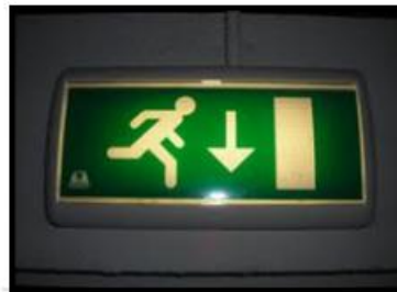
obr.3. nouzové osvětlení [11]
