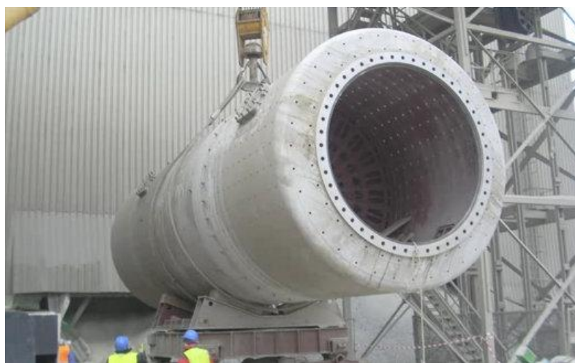
Obr. 7 Výměna cementového mlýna, Polsko [16]
