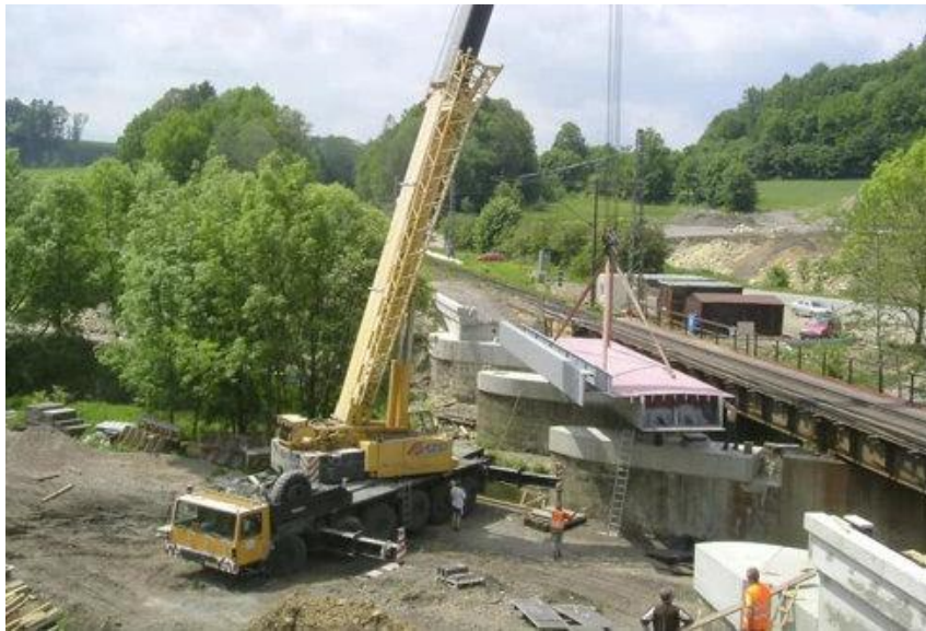
Obr. 6 Montáž železničního mostu [16]
