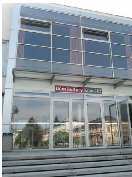
Obr. 18. Vstup do budovy Domu kultury
