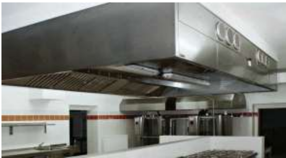
Obrázek 9.4 – Odsávací zákryt – digestoř (vlevo) a větrací strop (vpravo) [8]
