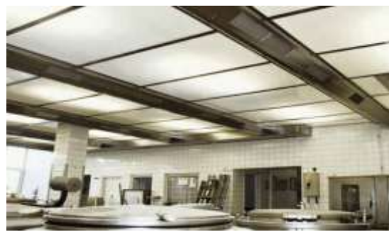
Obrázek 9.4 – Odsávací zákryt – digestoř (vlevo) a větrací strop (vpravo) [8]
