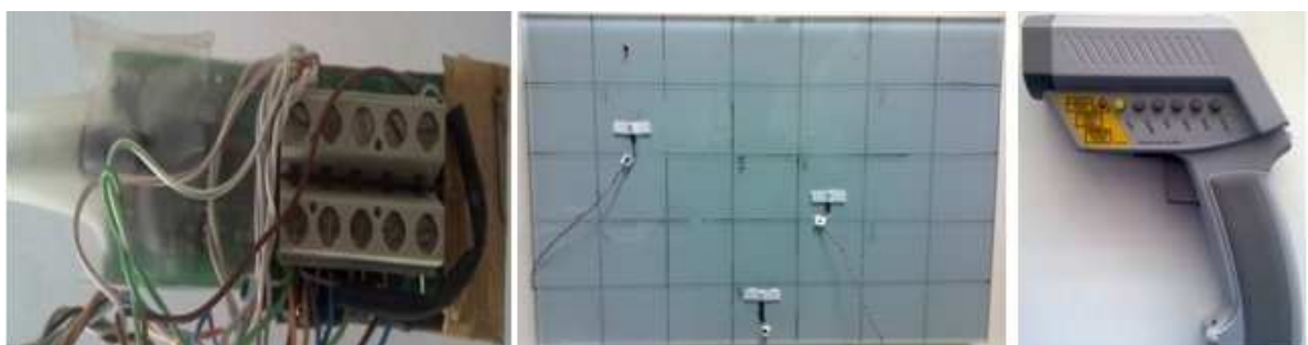
Obr. 31 Jednotka DLP-IO8, rozmístění čidel na panelu a pyrometr Agema TPT 64P
