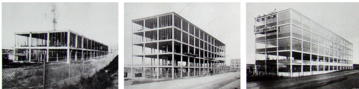
Obr. 6: 3 fáze výstavby strojírný
