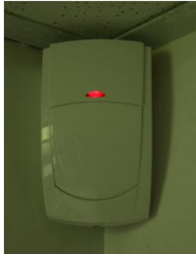
Obr. 23: Namontovaný PIR snímač
