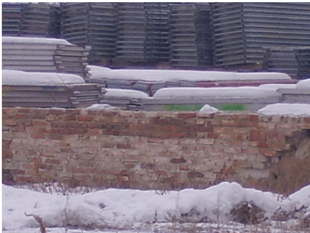
Obr. 20. Foto nízkého zdiva ze sousedního objektu
