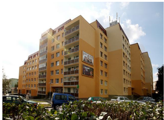
Revitalizace domu Murmanská, Praha 10 | 2009, Adresa: Murmanská 1468-1474, Praha 10 Charakter stavby: Zateplení systémem Baumit, výměna oken, sanace lodžii a vstupů Doba realizace: 02/2009 -08/2009, Hodnota díla: 21,1 mil. Kč
