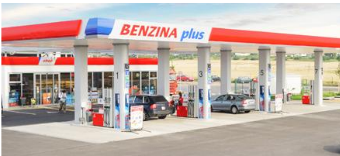
Obr 1. Čerpací stanice Benzina Plus
