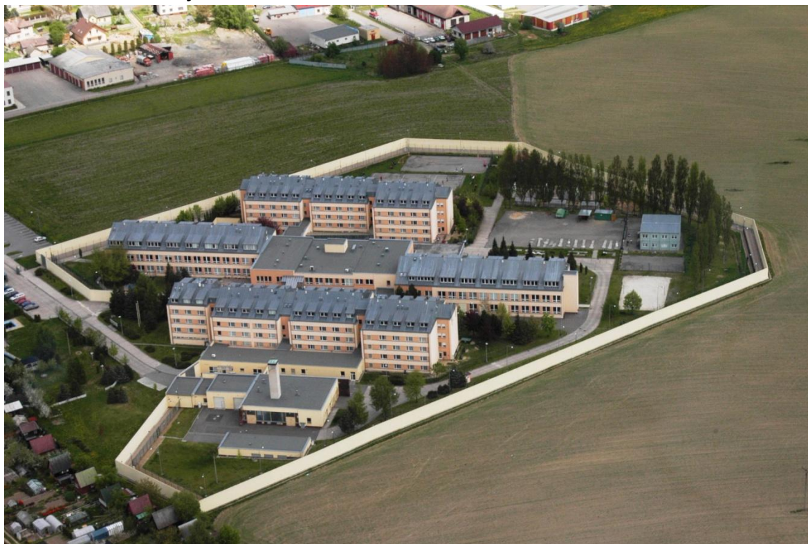
Obrázek č. 3: Letecký snímek Věznice Světlé nad Sázavou
