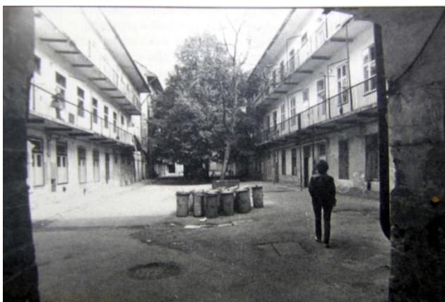
Obrázek 6 Bratislavská 41 rok 1987, kde dnes funguje projekt komunitního bydlení (Kuča, 2000, s.324)
