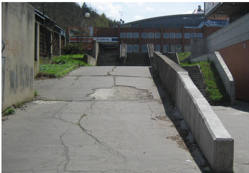
Obr. 30 Schodiště k zimnímu stadionu Lud'ka Čajky
