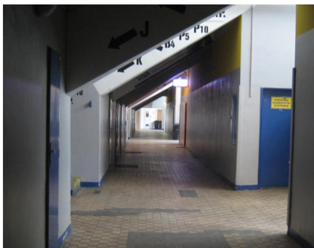
Obr. 32 Chodba na stadionu – Západní tribuna
